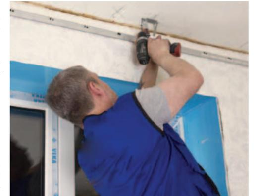
ми и обоями под покраску. Хотя нагрев ПВХ-пленки при монтаже натяжного потолка происходит точно и не вредит предметам обстановки, непосредственно в месте нагрева у стены температура достаточно высокая. Краска под воздействием горячего воздуха может слезть или изменить первоначальный цвет.
