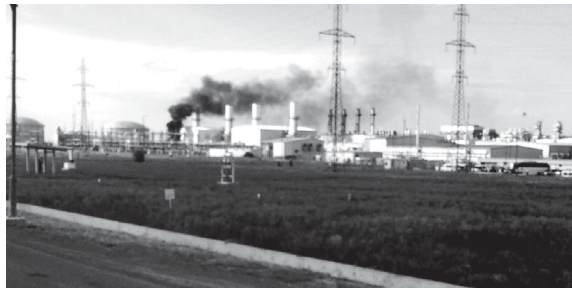
• На Карачаганакском месторождении 5 июня произошла авария, в результате которой сгорел трансформатор. Фото очевидца
