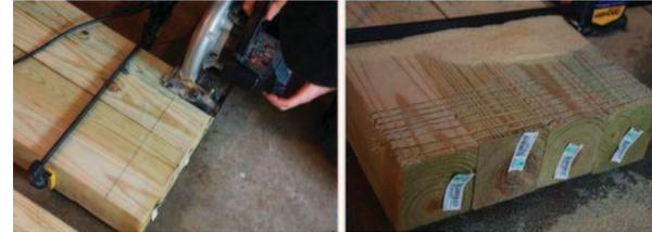
Такие же углубления сделайте в противоположной поверхности балок.
