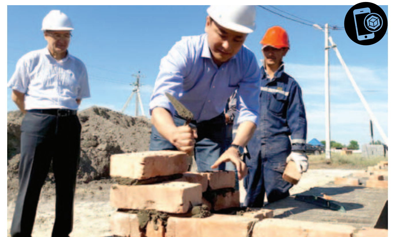
Осматривая одно из строящихся зданий, Кульгинов продемонстрировал сноровку каменщика. Он взял в руки строительный мастерок и положил пару рядов кирпичей в стене трехкомнатного дома в селе Аралтал.
