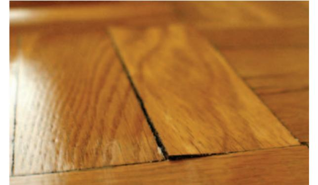
рассыхания и трещин. Усилить их крепление возможно за счёт шурупов с потайными головками. Иногда, если обнаружить лаги не удастся, придется частично вскрыть пол, поднять те доски, которые вызывают проблему, чтобы увидеть их.
